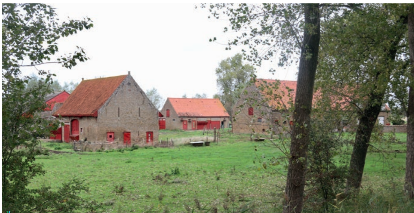
Foto. Hoeve 'Zwarte Sluize', Damse Vaart-Noord 45, Hoeke. Links de 19 de -eeuwse bakstenen éénbeukige dwarsschuur, onder pannenzadeldak en met uilengat in de topgevel. Rechts in 1925 heropgebouwd boerenstalhuis. Foto Arnout Zwaenepoel, 2019.
