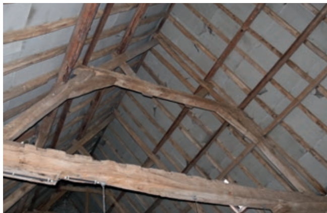
Foto. Gebinte van de schuur van de domeinhoeve in Tillegem (Sint-Michiels, Brugge). De trekbalken rusten op een eenvoudige muur. De hoeve dateert van 1894. Foto Arnout Zwaenepoel, 2019.
