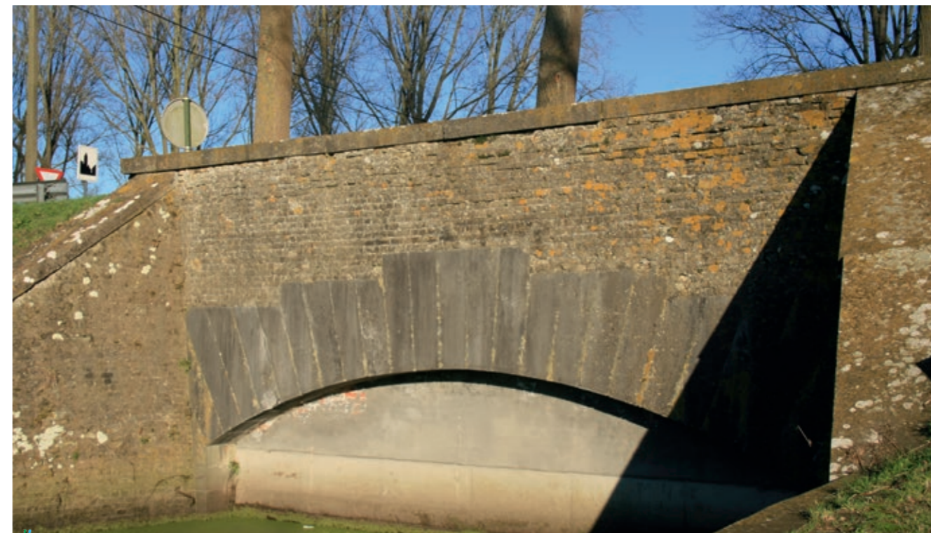
Foto. Uitwateringspunt ten westen van het Schipdonkkanaal. In 1855 werd het Schipdonkkanaal gegraven. Aan de westelijke kant van het Leopoldkanaal wijzigde de situatie in die zin dat de waterlopen opnieuw doorsneden werden. De waterlopen werden door middels van sifons onder het Schipdonkkanaal verbonden met de uitwateringspunten. Foto Arnout Zwaenepoel, 2013.
