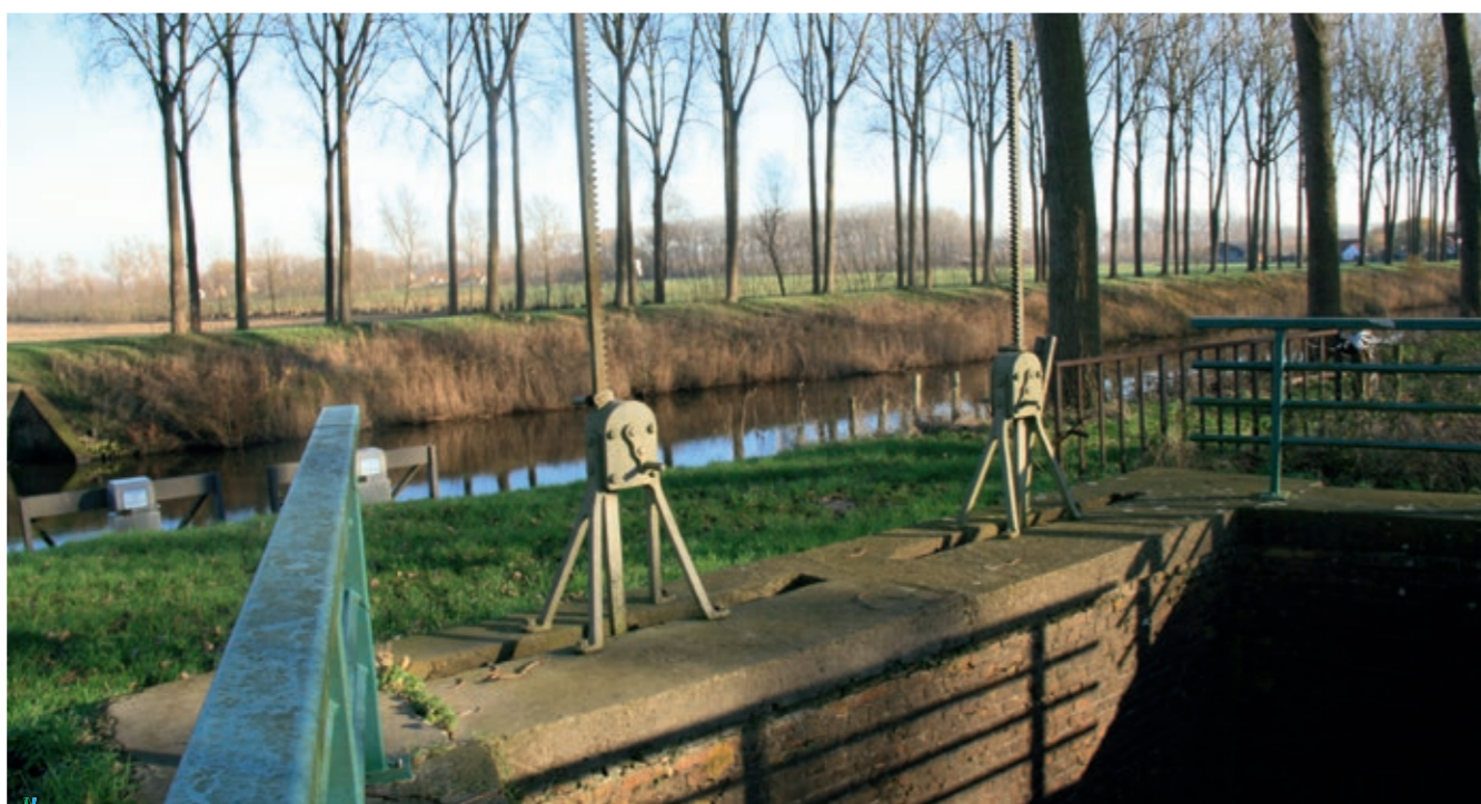
Foto. Deze uitwateringssluisjes aan de westelijke zijde van het Leopoldkanaal werden gemaakt in 1845, om de Zwinnevaart (Eienbroekvaart) te laten vervolgen. Het Schipdonkkanaal was er toen nog niet. In 1855 werd het Schipdonkkanaal gegraven en kwamen deze sluisjes op de middendijk tussen Leopoldkanaal en Schipdonkkanaal te liggen. Foto Arnout Zwaenepoel, 2013.
