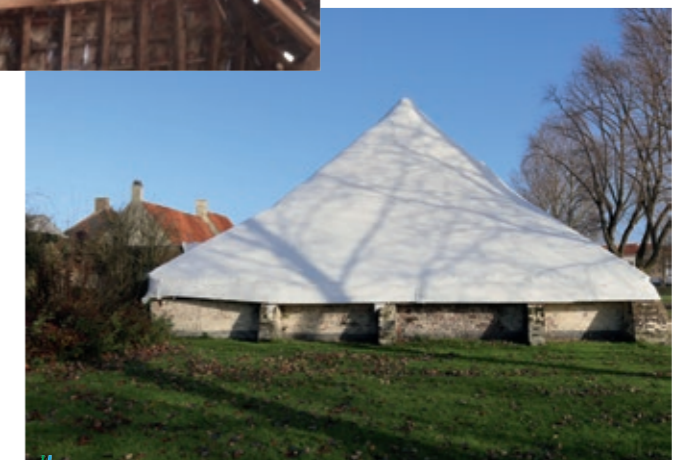
Foto. De schuur van 't Boerenhof in Heist is momenteel ingepakt in een beschermende plastic. In 2020 wordt de restauratie aangevat. Foto Arnout Zwaenepoel, 2019.
