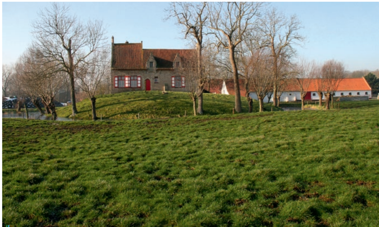
Foto. Het Kasteelken of Schottenhof in Dudzele, een mooi voorbeeld van opper- en neerhof, typologisch gesitueerd tussen de adellijke mottes en de sites met walgracht. De huidige gebouwen van het opperhof zijn 17 de - en 20 ste -eeuws. De eenbeukige dwarsschuur van het neerhof, in verankerde baksteenbouw en onder gebogen, mank zadeldak (Vlaamse pannen) heeft de jaartallen 1768 en 1778 op de dorsvloeren. Foto Arnout Zwaenepoel, januari 2015.
