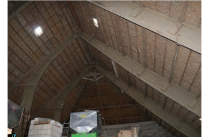
Foto. Asymmetrisch gebinte in Amerikaans grenen, in de wederopbouw schuur van hoeve Kruisweg, Trangel-West 66, Schoondijke. Let op de rietbedekking onder de pannen. Foto Arnout Zwaenepoel, 2019.
