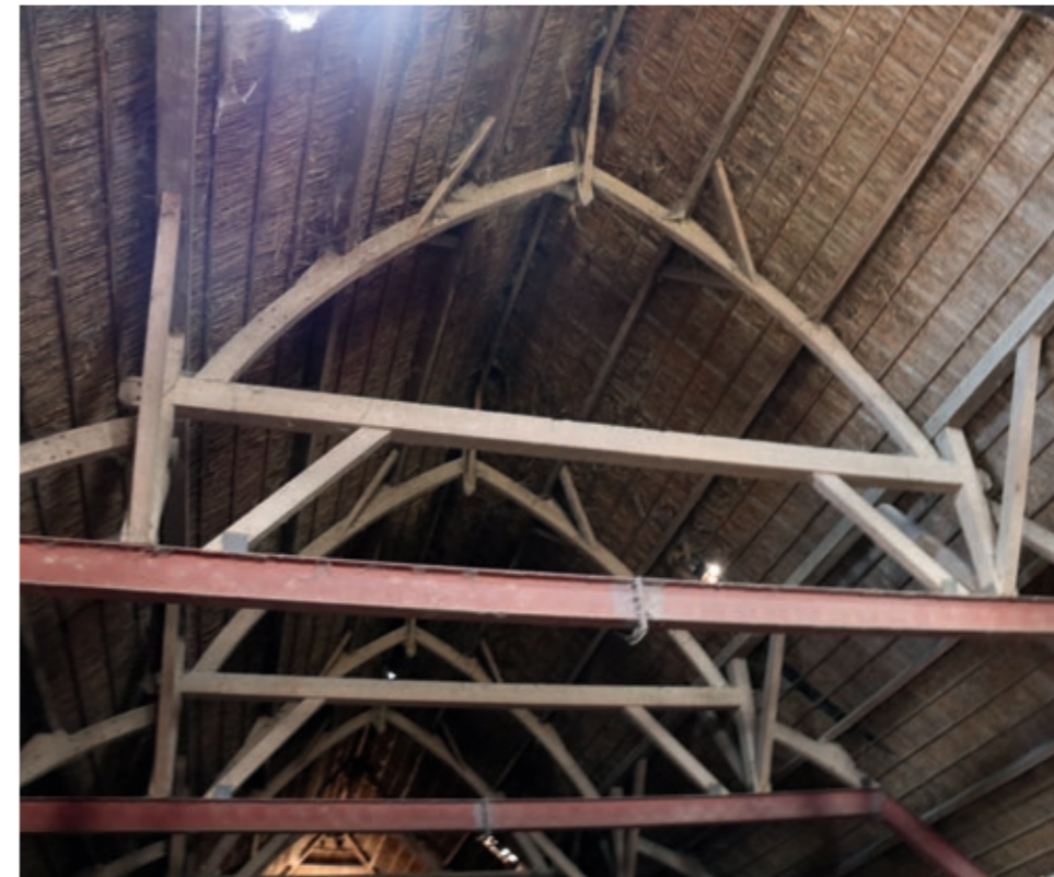
Foto. Het gebinte van de schuur uit 1911, Sluissedijk 27 in Zuidzande vertoont een eigenaardige combinatie van metalen en houten onderdelen. Foto Arnout Zwaenepoel, 2019.
