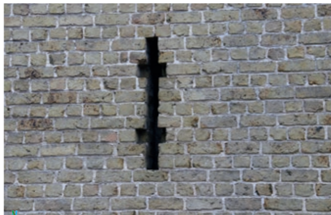
Foto. In de stenen graanschuurmuren komen meestal hoge smalle spleten voor om het graan te verluchten. De oudere spleten hebben boven, midden en onderaan een dwarse verbreding. Foto domeinhoeve Tillegem, 1894, Arnout Zwaenepoel, 2019.
