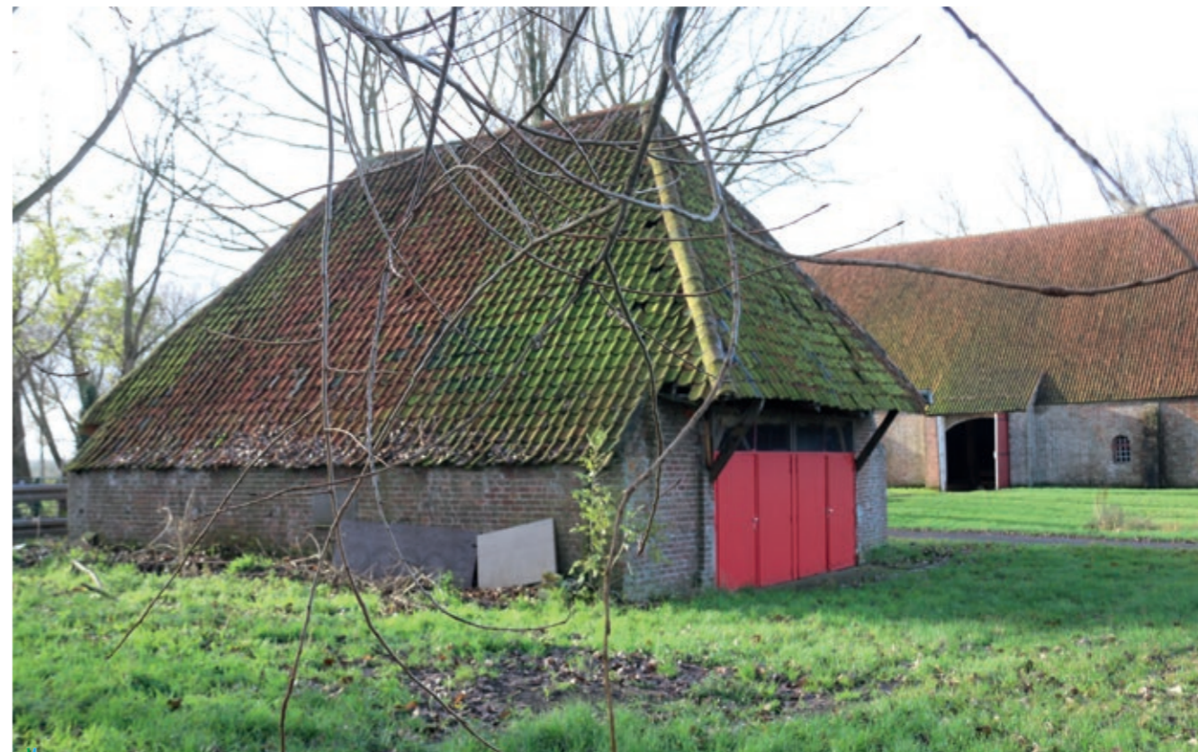
Foto. Wagenhuis van de site Groot Ter Doest in Lissewege. Het oorspronkelijke wagenhuis, met ankerbalkconstructie met schaargebinte en nokstijl en houten stijl- en regelwerk werd in de 19 de eeuw verbouwd met baksteen. Het oorspronkelijke gebinte is bewaard. Foto Arnout Zwaenepoel, 2019.
