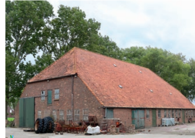
Foto. Dezelfde schuur gezien vanaf de andere zijde. Foto Arnout Zwaenepoel, 2019.
