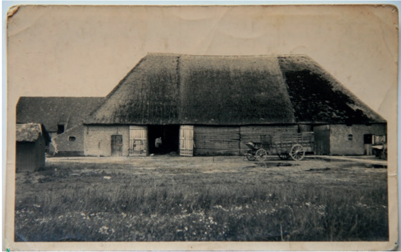
Foto. De monumentale dwarsschuur met schilddak van de boerderij Hazegrasstraat 61, Knokke-Heist, daterend uit 1783 en hier gefotografeerd in 1925. De schuur werd verwoest door de bombardementen van de Engelsen in de Tweede Wereldoorlog. Op de foto achteraan staat nog vermeld dat ze gebouwd werd met '52 eekenboomen. Foto uit het familiealbum van Jan Vandepitte.
