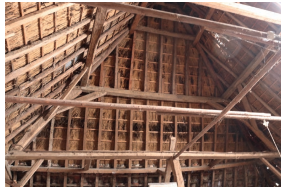
Foto. Ankerbalkgebinte van bergschuur te Dudzele. De kapstijlen van een bergschuur zijn omheen de tas in het vierkant opgesteld. Bij de sterk ontwikkelde bergschuren is de dakondersteuning zeer gecompliceerd. Uit het zware staander- en balkenwerk ontwikkelen zich een groot aantal schoorstukken. Foto Clemens v. Trefois.
