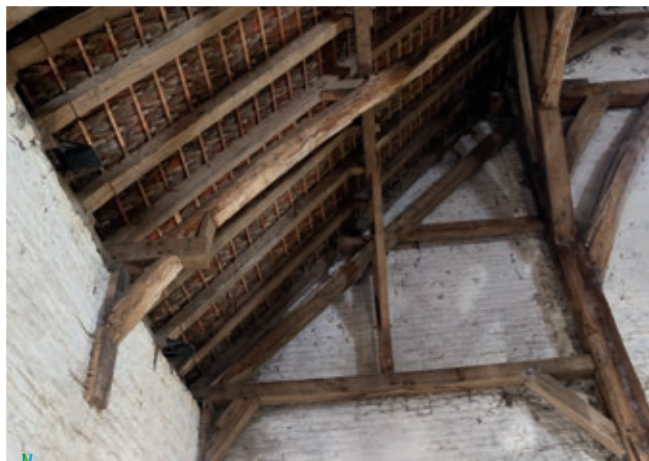
Vijf foto's. 1) Het indrukwekkende dekbalkgebinte van de schuur van Ter Doest, 2) de typische poort van een langsdeelschuur, 3) gordingen, 4) poer van een stijl en 5) gebinte van een zijbeuk. Foto's Arnout Zwaenepoel, 2019.
