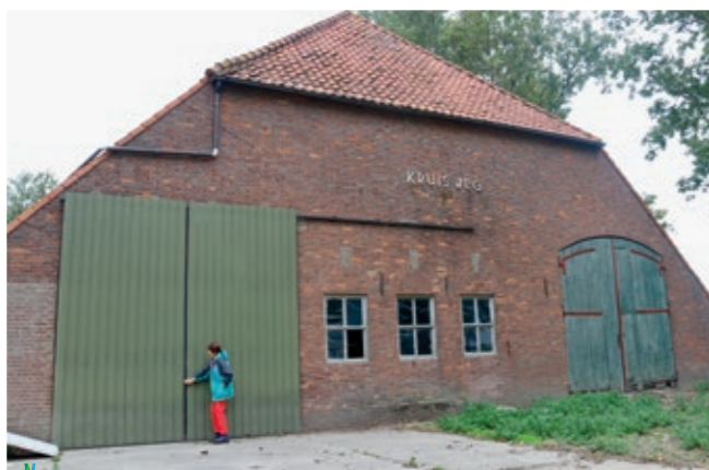
Foto. Voorkant van een wederopbouw schuur uit 1947 van de boerderij Kruisweg, Trangel-West 66, Schoondijke. Bakstenen schuur met pannen wolfstdak. Ramen in alle gevels zorgen voor licht binnenin. De metalen poort is een vervanging van de oorspronkelijke poort. Foto Arnout Zwaenepoel, 2019.
