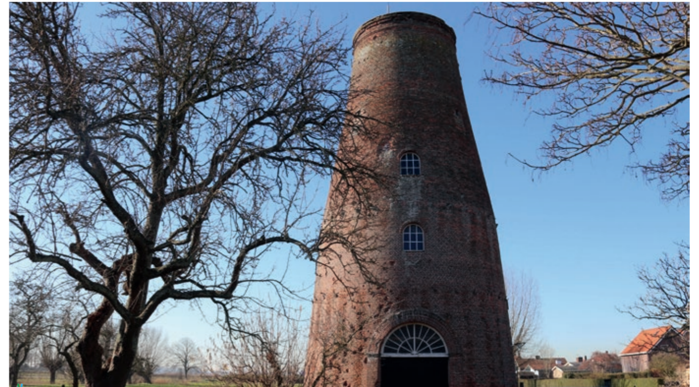
Foto. Bakstenen molenromp van de grondzeiler in het centrum van Nieuwvliet, een korenmolen uit 1850. Foto Arnout Zwaenepoel, 2019.
