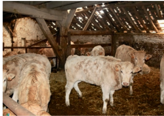
Foto. Ankerbalkgebinte in de stal van de schuur. Ook de tweebeukige indeling is goed waarneembaar. Daarboven, niet zichtbaar op de foto, brede jukbalk van mansardedak. Foto Arnout Zwaenepoel, 2019.
