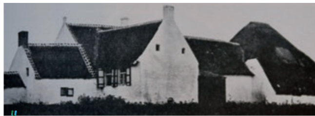
Foto. Boerderij met aangebouwde bergschuur in Stalhille. Het is dit type hoeves dat in de romantische tijdssfeer van eind 19 de eeuw aanleiding gaf tot het idee van de zogenaamde 'Friese kop-hals-romphoeves' in West-Vlaanderen. Clemens v. Trefois toonde aan dat dit idee niet correct is. De vroeger losstaande bergschuur en het woonhuis werden pas in de 19 de eeuw aaneen gebouwd door een tussengebouw. Foto Clemens v. Trefois.
