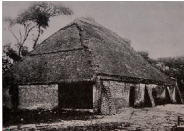
Foto. Bergschuur met schilddak uit Westkapelle. De bergschuur is een indrukwekkende constructie waarin dikwijls stallen; oogst en schuurreed samen onder één dak zijn gebracht. Foto Clemens v. Trefois. Bron: Clemens v. Trefois (1978). Landelijke architectuur. Uitg. Danthe, Sint-Niklaas, 305 p.
