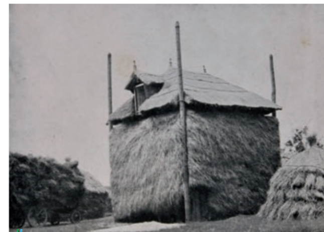
Foto. Paalschuur of vierroedenberg te Appels (Oost-Vlaanderen). Foto Clemens v. Trefois. Bron: Trefois, C. (1941).
