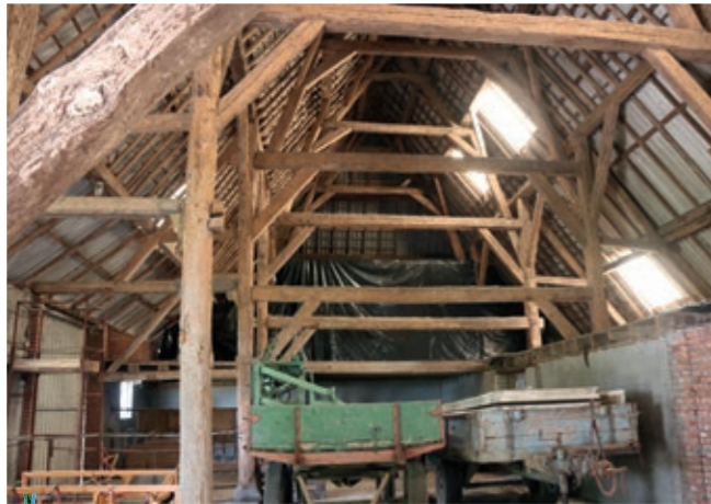
Twee foto's. Het buitenaanzicht van deze schuur naast de Biezenkreek in Sint-Kruis (Zeeuws-Vlaanderen) doet een 20ste-eeuws wederopbouwschuur vermoeden, maar het ankerbalkgebinte vanbinnen verraad een veel oudere constructie. Foto's Arnout Zwaenepoel, 2019.
