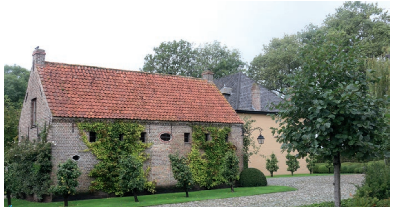
Foto. De paardenstal van het Vaucelleshof, Vredestraat 17 te Damme. De stal werd gebouwd in 1887. Foto Arnout Zwaenepoel, 2019.
