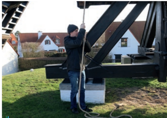
Vier foto's. De Kalfmolen op de Graaf-Jansdijk in Knokke. Standaardmolen van circa 1770, met twee koppels maalstenen en een haverpletter. 1) buitenaanzicht, 2) de haverpletter, 3) op verschillende balkstukken komen data voor: 1733, 1734, 1763 en 1770. De molen is daarmee moeilijk exact te dateren, 4) molenaar Stijn Van Cauwenberghe lost de vang. Foto's Arnout Zwaenepoel, 2019.
