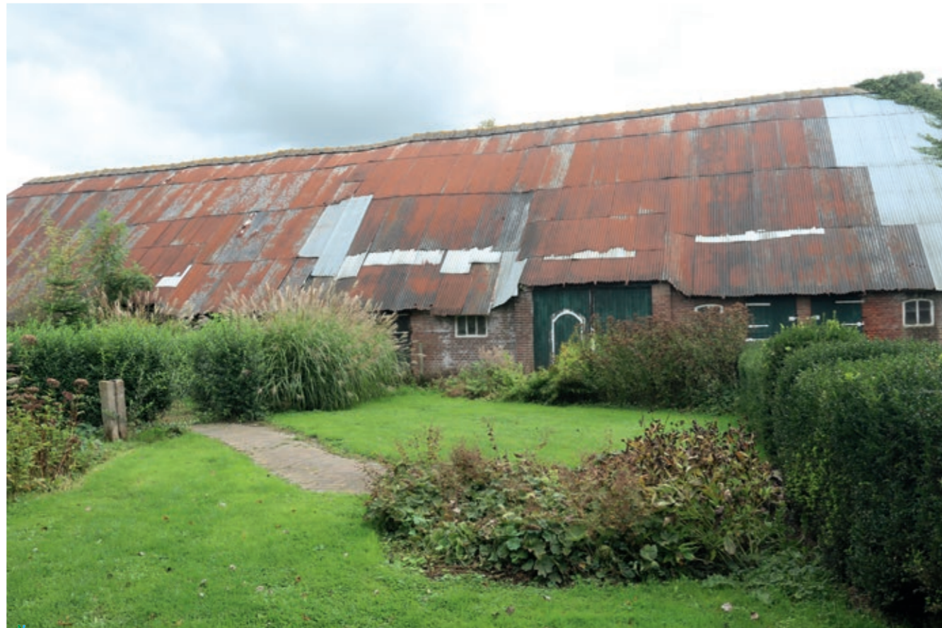
Foto. Dwarsschuur met twee doorritten, uit het laatste kwart van de 17 de eeuw, Sasputse straat 14, Schoondijke. Het strooien dak van weleer is door golfplaten vervangen en de langsevels aan één zijde door baksteen en aan de andere zijde door betonstenen. Foto Arnout Zwaenepoel.
