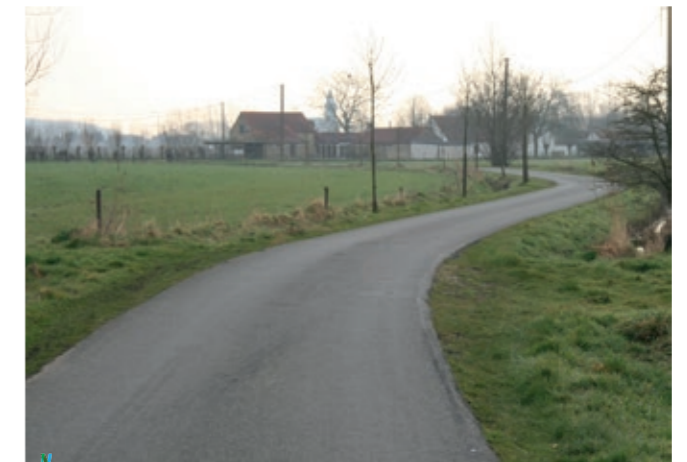
Foto. De Damweg in Moerkerke. Vermoedelijke oprichting kort na 1180. Foto Arnout Zwaenepoel, 2015.
