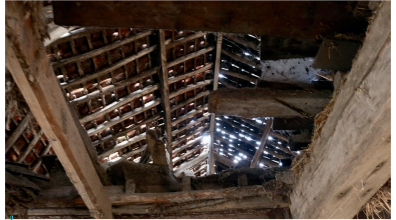
Foto. Nok, gordingen en kepers van het mansardedak van de schuur van De Stamper. Foto Arnout Zwaenepoel, 2019.
