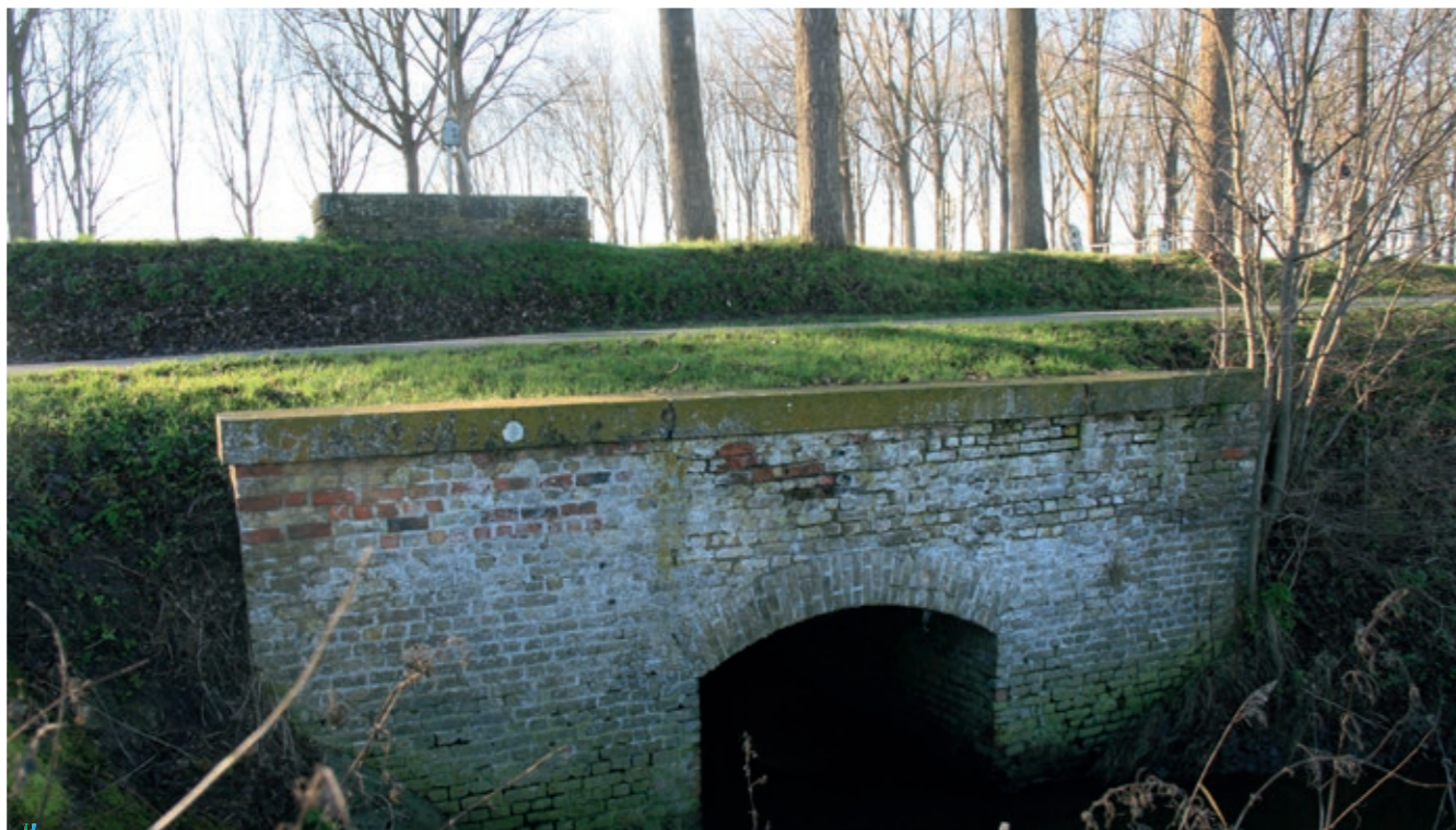
Foto. Het Leopoldkanaal is gegraven in 1845. Op dat moment werden de meeste waterlopen die toen 'afgesneden' werden, gekoppeld aan het nieuwe kanaal. Dit gebeurde door middel van uitwateringssluisjes (rabotten) aan de oostkant van het kanaal, zoals te zien op de foto, bij de uitwatering van de Zwinnevaart (Eienbroekvaart) aan de Groene Wandeling bij Oostkerkebrug. Foto Arnout Zwaenepoel, 2013.
