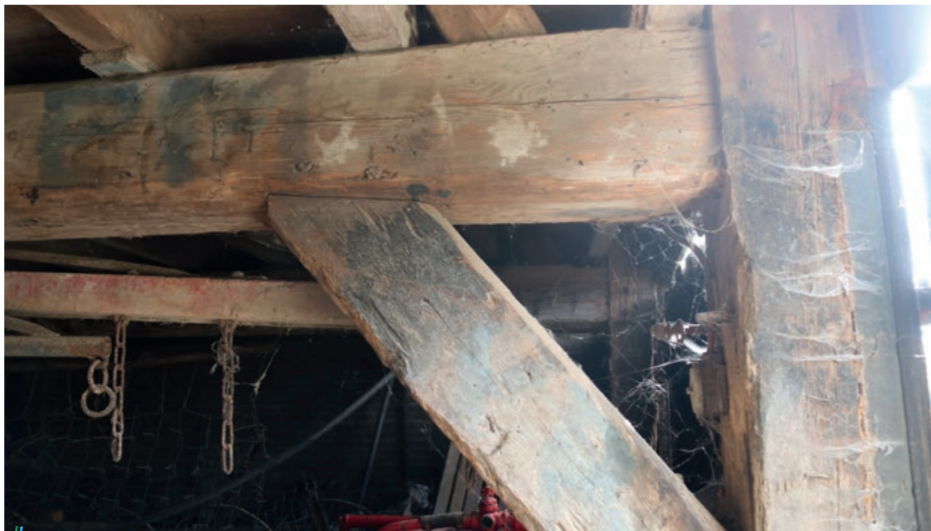
Foto. Gedeelte van ankerbalkgebinte van het vermoedelijk 18de-eeuwse wagenhuis van Kienstee, Sasputsestraat 11, Schoondijke, anno 2019. Foto Arnout Zwaenepoel, 2019.
