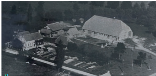
Foto. Hoeve Kruisweg, Trangel-West 66, Schoondijke, gefotografeerd in 1939. De met stro of riet gedekte langsschuren hadden schilddaken. Het woonhuis en het wagenhuis waren met pannen gedekt. Op basis van een bewaard tegeltableau uit het huis, moet het huis waarschijnlijk gebouwd zijn in het laatste kwart van de 18 de eeuw. Foto private collectie familie Risseeuw-Decker.
