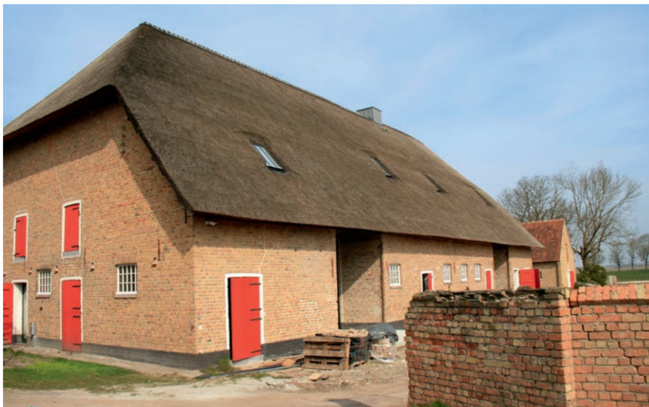
Foto. De grote dubbele dwarsschuur van De Grote Stelle (Hazegrasstraat 120, Knokke-Heist) heeft enkele bedrieglijk oudere trekjes. Wolfsdak en rieten dakbedekking doen een 18 de -eeuwse schuur vermoeden. In werkelijkheid is de schuur gebouwd in 1885 ter vervanging van de oudere, afgebrande eind 18 de -eeuwse schuur. In de schuur waren tasruimte, koeinstallen hoozolders en bietenopslagplaats voorzien. Een foto van 2005 toont nog een pannendak. Bij de herinrichting als woning in 2014 werd een rieten dak aangebracht. Foto Arnout Zwaenepoel, 2015.
