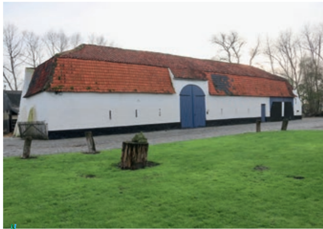
88 Foto. Monumentale tweebeukige dwarsschuur van zes traveeën en hooizolder, met geïncorporeerde koestal en tweeledig wagenhuis, onder mansardedak met dakoversteek, opgetrokken in 1759 (cf. jaartal in trekbal). Steunberen tegen de oostgevel, luchtspleten. Centrale inrit onder sleepdak, met poort met rondboog. Foto Arnout Zwaenepoel, 2019.
