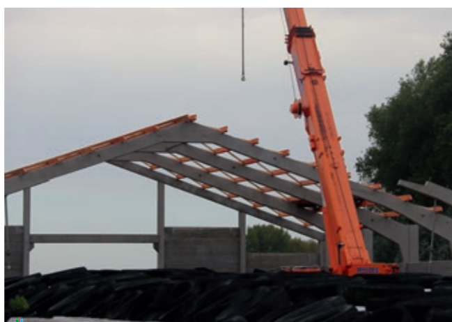
Foto. Nieuwe betonnen loods naast de 18 de - en 19 de -eeuwse gebouwen van 't Oosthof, Krinkeldijk 1 te Oostkerke. Foto Arnout Zwaenepoel, 2019.
