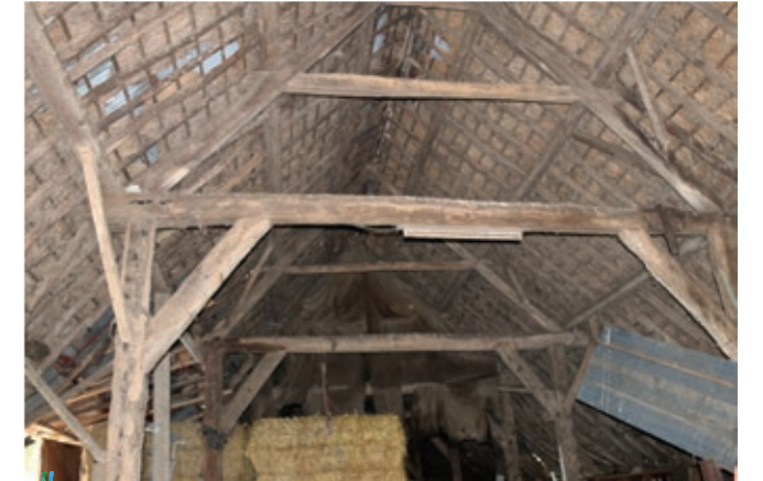
Foto. Gebinte van de 17 de -eeuwse schuur van Sasputse straat 14 te Schoondijke. Het gebinte van de onderste bouwlaag is een dekbalkgebinte: de gebintbalk steekt niet door de gebintstijlen heen als bij een ankerbalkgebinte, maar ligt er opgestapeld en dekt dus de stijlen als het ware af. Stijl en balk worden verstevigd door gebintbalkschoren. De tweede bouwlaag is het dakspant. Het bestaat hier uit twee rechte jukstijlen en twee jukbalken. De jukbalken zijn tegen de jukstijlen bevestigd en niet erdoor. Aan elke zijde van het dak zijn er drie gordingen aanwezig: één gording op de gebintbalk en één op elke jukbalk. Bovenaan zit de nokgording. De kepers bestaan uit ruwe stammetjes of persen en nog niet uit vierkant gezaagde of geschaafde balkjes. De onderste gording wordt ook door schoren tussen gording en gebintstijl verstevigd. Op de kepers zijn latten geslagen waarop het stro dan aangebracht werd. Foto Arnout Zwaenepoel, 2019.
