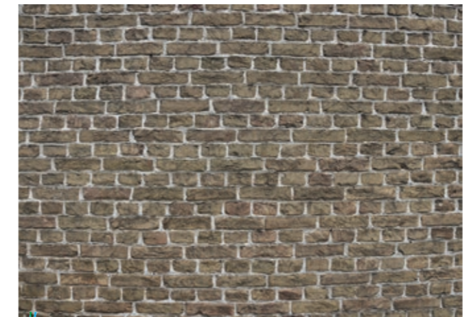
Foto. Het woonhuis van de boerderij Sasputse straat 14 te Schoondijke was 17 de -eeuws, maar is zeer sterk gewijzigd in de loop van de tijd. De bakstenen zijn evenwel nog altijd de originele 'IJsselsteentjes'. Foto Arnout Zwaenepoel.
