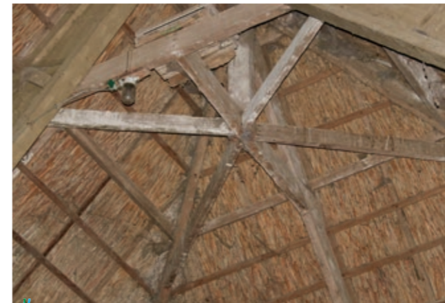
Foto. Detail van het gebinte in de nok aan de topgevel van de wederopbouw schuur van hoeve Kruisweg, Trangel-West 66, Schoondijke. Foto Arnout Zwaenepoel, 2019.
